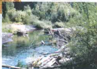
←復旧工の完成:河岸に覆土し、ヤナギ類を挿し木して植生の回復を図る:1994年11月
