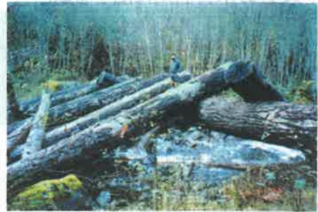
上流からの流木を捕捉するために、巨木により造られた木製施設(米国)
