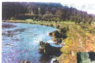
←復旧工の完成:河岸に覆土し、ヤナギ類を挿し木して植生の回復を図る:1994年11月
