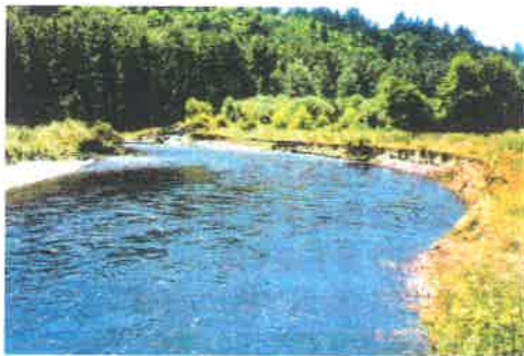
米国ワシントン州グリーン川における洪水災害後の右岸浸食状況:1994年6月
