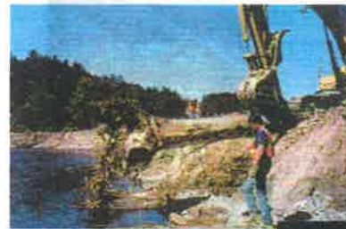
長さ約7m、直径約80cmのスギの根付き丸太の設置:1994年8月
