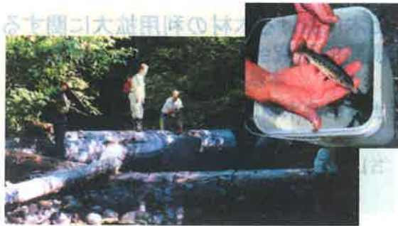
複数の丸太を組み合わせて作られたウエッジダム (米国)
