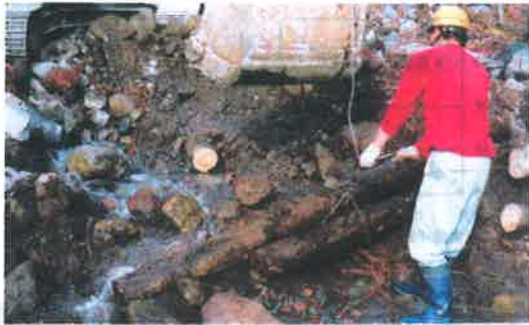
木製床固工の解体・部材採取(2002年12月)
