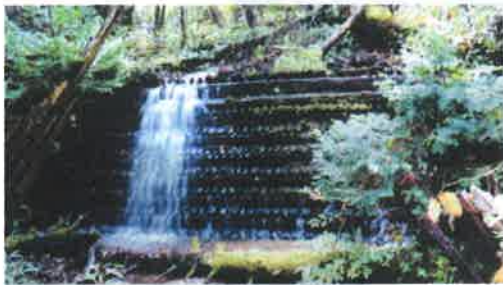
青森県坪毛沢No.4堰堤(1954年竣工、ヒバ)、 有効高3.0m、堤長14.7m
