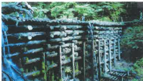
静岡県流沢No.1堰堤(1959-60年施工:モミ・ツ ガ、1975年および1990-91年補修:米マツ、米 ツガ)、有効高8.0m、堤長24m、天端幅5m
