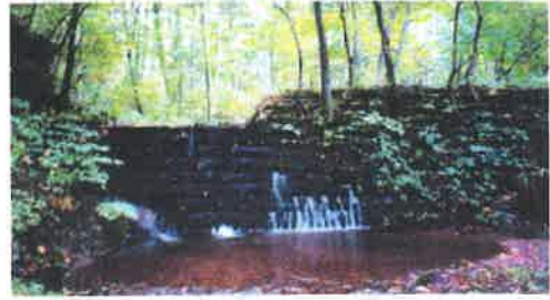
青森県坪毛沢No.1堰堤(1958年竣工:ヒバ) 有効高2.5m、堤長18m、天端幅1.3m
