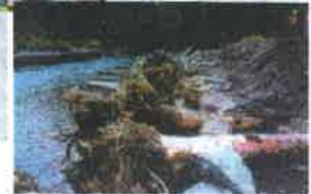
長さ約7m、直径約80cmのスギの根付き丸太の設置:1994年8月
