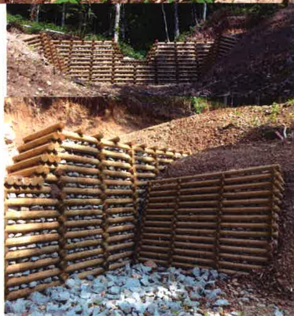
← 下流の前年度施工の土留工(ダム式)
