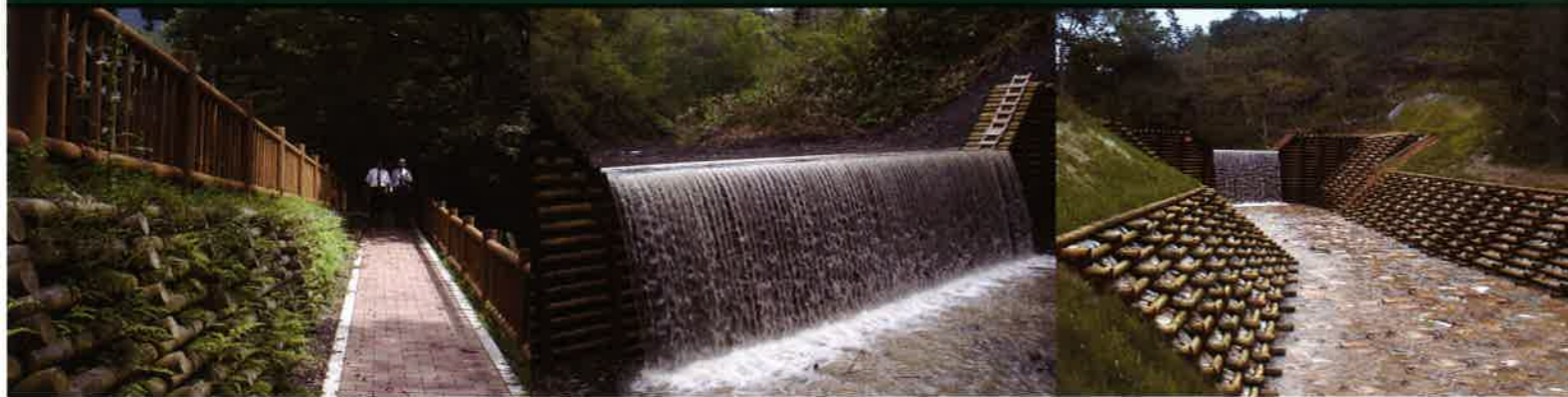
高知県 生活環境保全整備事業（土留工）
