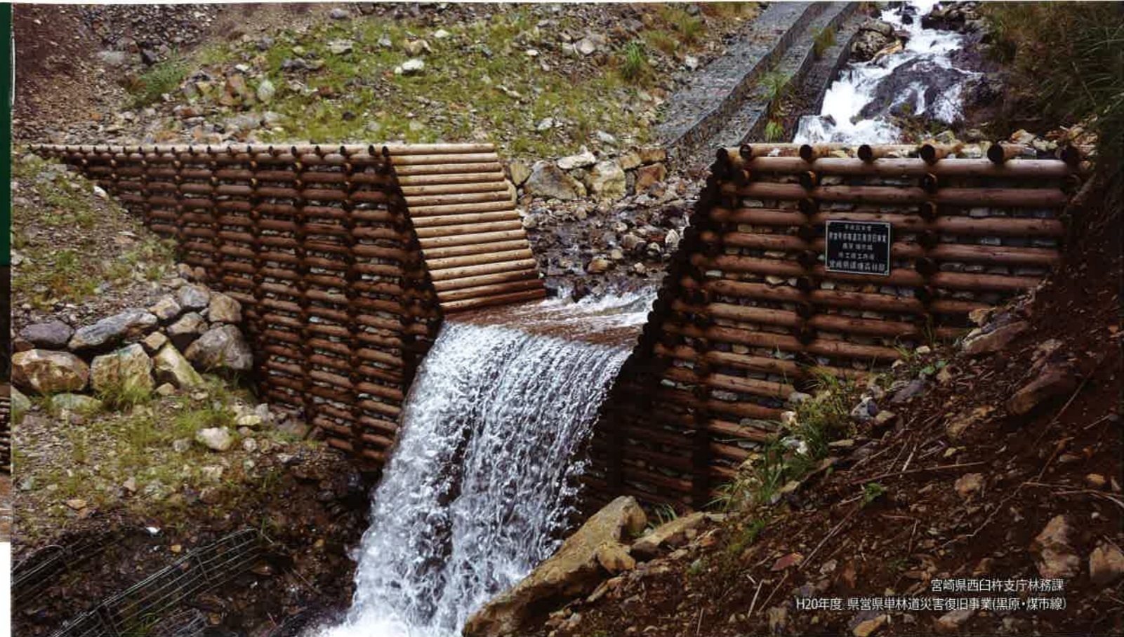
広島県 生活環境保全林整備事業溪間工事（護岸工）
